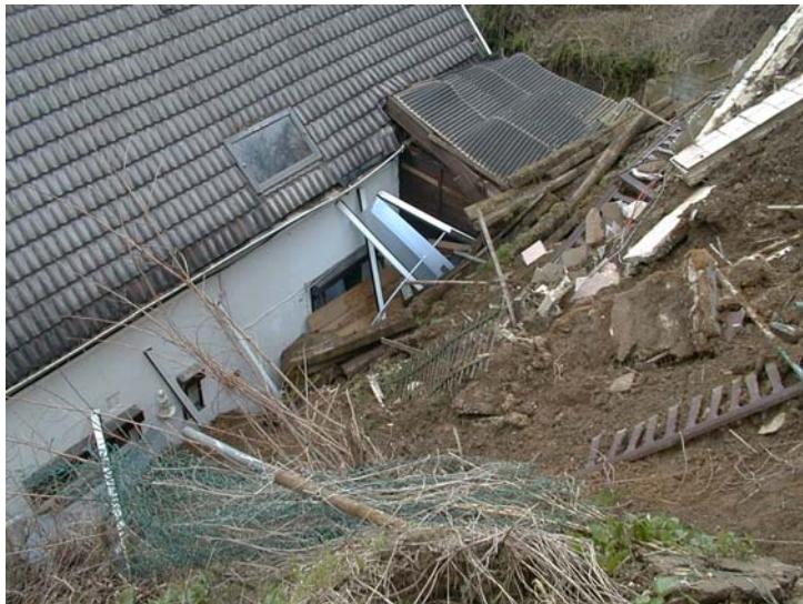
Verschüttung eines Wohnhauses in Maastricht, Niederlande, durch eine Rutschung.
