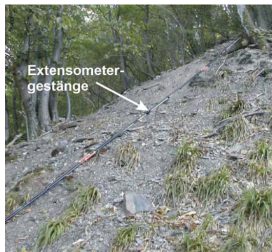
Abb. 7. Über einen Rutschhang verlegte Oberflächenextensometer.
