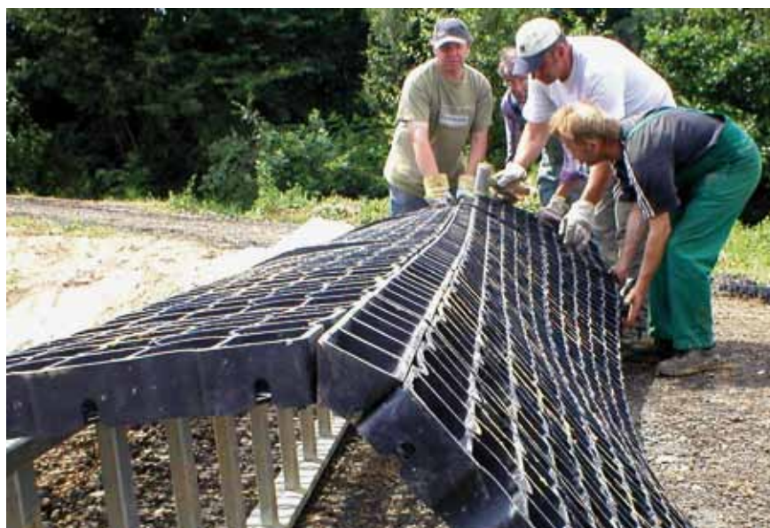
Bild 1: Vorverlegen einer Rasengitterfläche mit Böschungswinkelelementen
