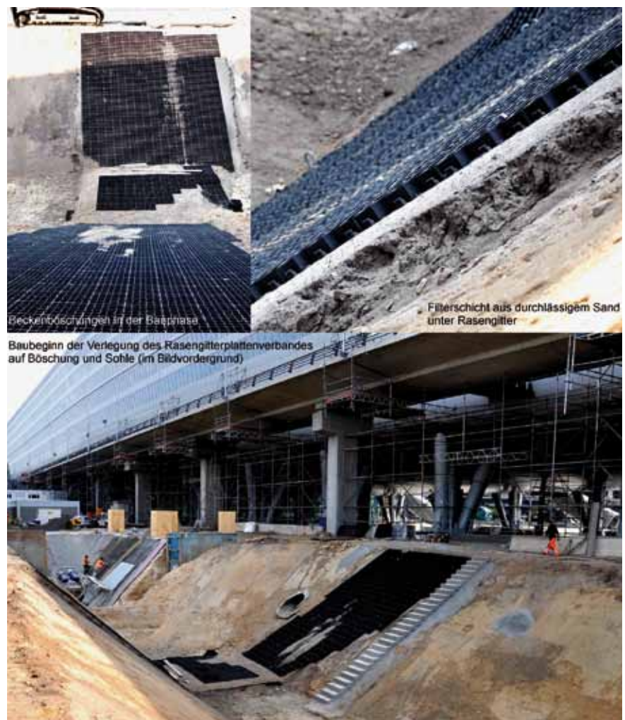
Bild 4: Versickerungsbecken in der Bauphase, The Squire Flughafen Frankfurt/Main
