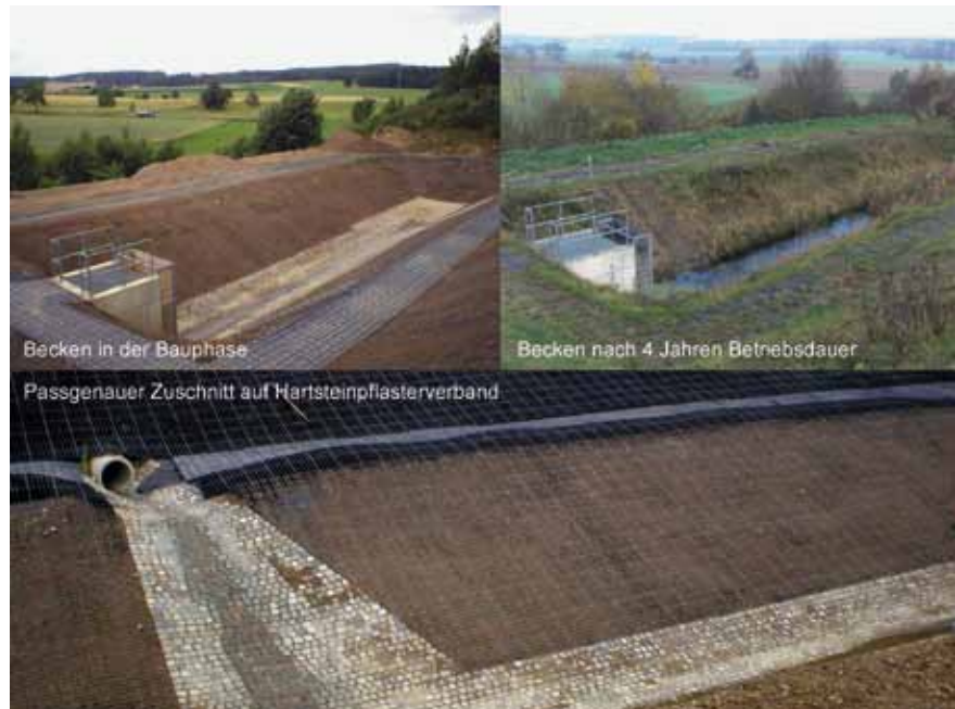
Bild 5: Regenrückhaltebecken, Betriebsgelände in Arzberg
